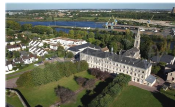
Vue aérienne - Isfec Normandie
