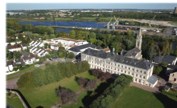
Vue aérienne - Isfec Normandie
